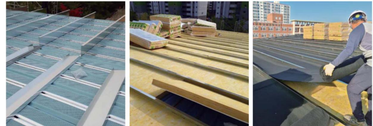
04. Z-BAR 설치 05. 단열재 설치 06. 내화내열차단재 부착
