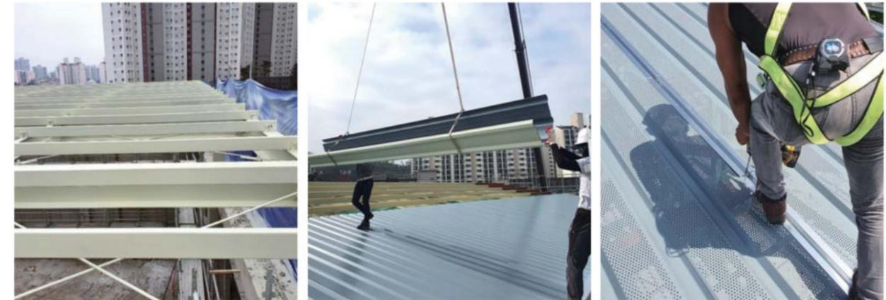
01. 하부데크패널 실측/발주 02. 하부데크패널 설치 03. U-RAIL 설치
